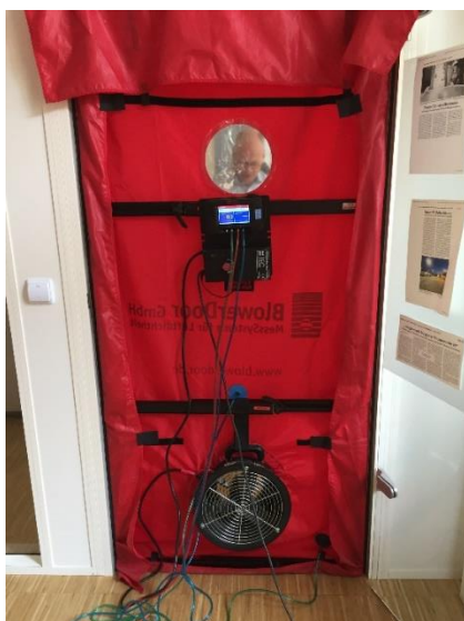
Blower-Door®-Test im Einsatz ©KEK
